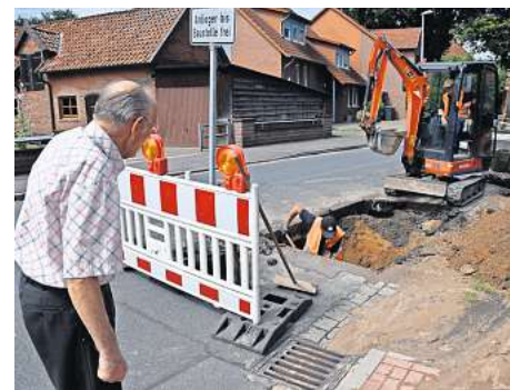
Anwohner Wilfried Kuske (von links) sieht zu, wie Karahan Veyssel und Karsten Milewski unter der Straße nach dem Rohrschaden suchen. FOTO: KATHRIN GÖTZE
