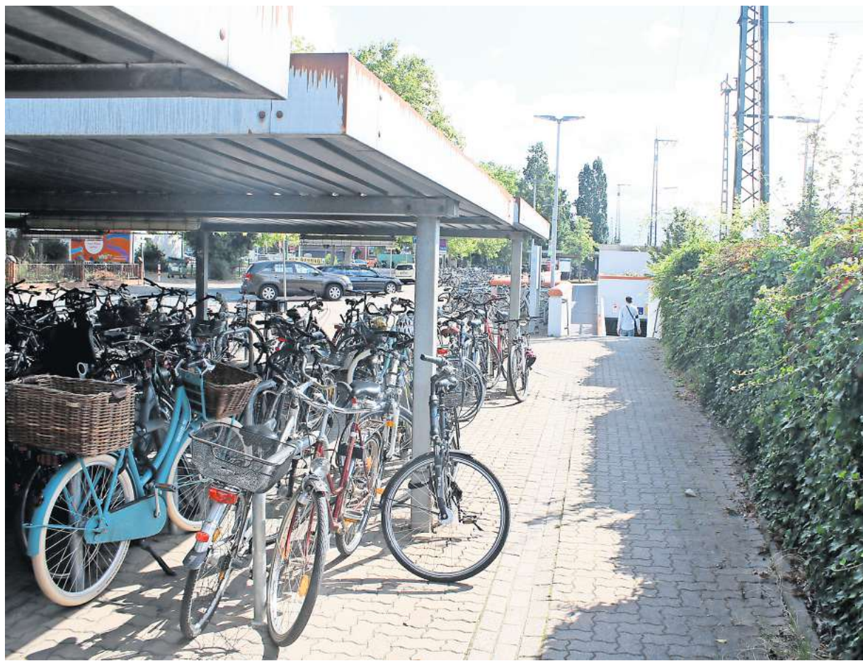
Diese Anlage auf der Nordseite soll eine zweite Etage bekommen.
