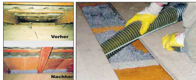
Eine Einblasdämmung verhindert wirksam Wärmeverluste etwa über das Dachgeschoss oder durch Hohlräume. Foto: Deike & Sohn
