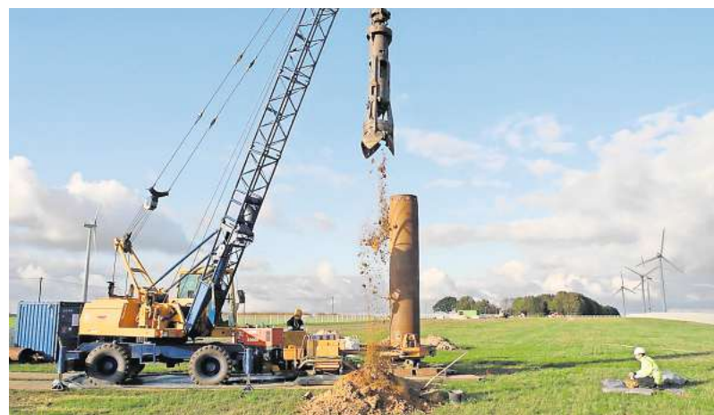
Im Wasserschutzgebiet Forst Esloh wird ein neuer Brunnen gebohrt.
