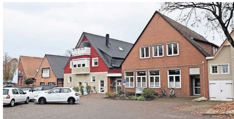
Die Scheunenreihe am Schützenplatz: Außer der giebelständigen Ausrichtung der Gebäude ist von der historischen Ansicht nicht mehr viel zu erkennen.
